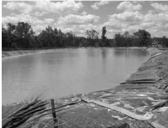
Fot. 1. Zbiornik na wodę zlokalizowany na terenie Marcellus Shale, USA (Modern Shale... 2009)
