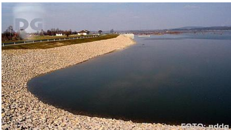
Fot. 3. Zbiornik przeciwpowodziowy Kuźnica Wareżyńska
