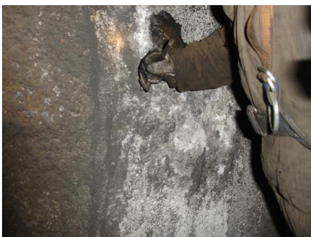
Fot. 10. Przygotowywanie obmurza betonowego do badań nieniszczących
