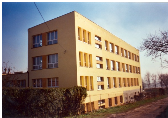
Fot. 1. Obiekt szkoły A po wykonaniu usprawnień termomodernizacyjnych, poprawie sprawności systemu grzewczego i wymianie źródła ciepła (fot. L. Malara)
