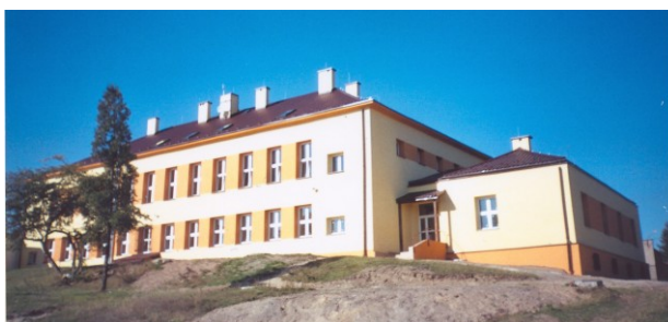
Fot. 4. Obiekt szkoły D po wykonaniu usprawnień termomodernizacyjnych i poprawie sprawności systemu grzewczego (fot. L. Malara)
