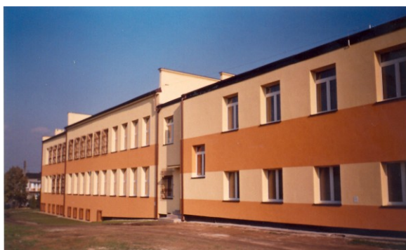
Fot. 2. Obiekt szkoły B po wykonaniu usprawnień termomodernizacyjnych, poprawie sprawności systemu grzewczego i wymianie źródła ciepła (fot. L. Malara)
