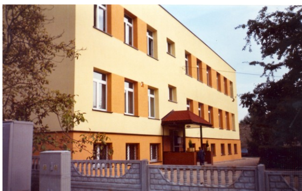
Fot. 3. Obiekt szkoły C po wykonaniu usprawnień termomodernizacyjnych i poprawie sprawności systemu grzewczego (fot. L. Malara)
