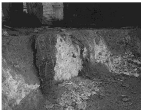
Fot. 1. Proces rozkładu fundamentu przed oddziaływaniem elektrohydraulicznym
