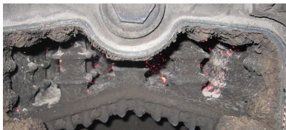
Fot. 1. Wypalanie sadzy na powierzchni wymiennika ciepła Photo. 1. Soot combustion on the surface of heat exchanger
