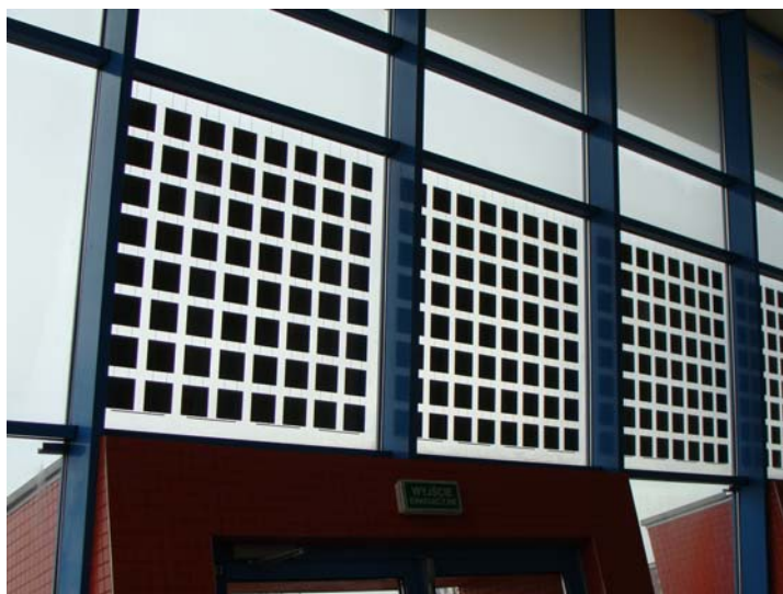
Fot. 7. Zainstalowane moduły ogniw fotowoltaicznych na południowej części przeszklenia Hali Widowskowo-Sportowej (fot. L. Malara)
