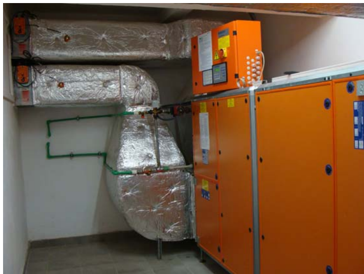
Fot. 4. Centrala wentylacyjna nawiewno-wywiewna dla pomieszczeń sanitarnych (fot. L. Malara)
