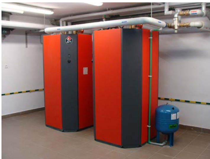
Fot. 3. Modernizacja dwufunkcyjnego węzła ciepłowniczego – system ciepłej wody użytkowej (fot. L. Malara)
