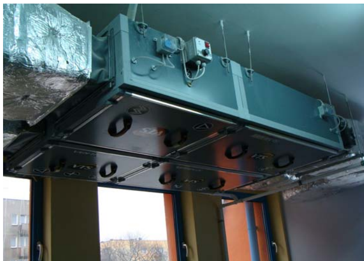
Fot. 5. Centrala wentylacyjna nawiewno-wywiewna dla pomieszczeń sportowych (sala gimnastyczna i fitness) (fot. L. Malara)
