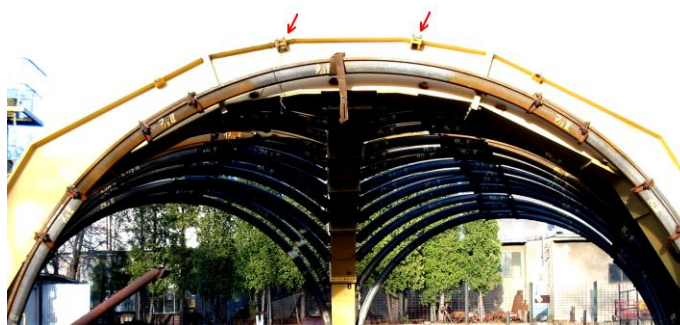
Fot. 2. Fragment konstrukcji obudowy odgałęzienia z zaznaczonymi uchami do przykotwienia (fot. T. Dragon) Photo 2. Fragment of construction of roadway junction support with marked lugs for fastening (photo T. Dragon)
