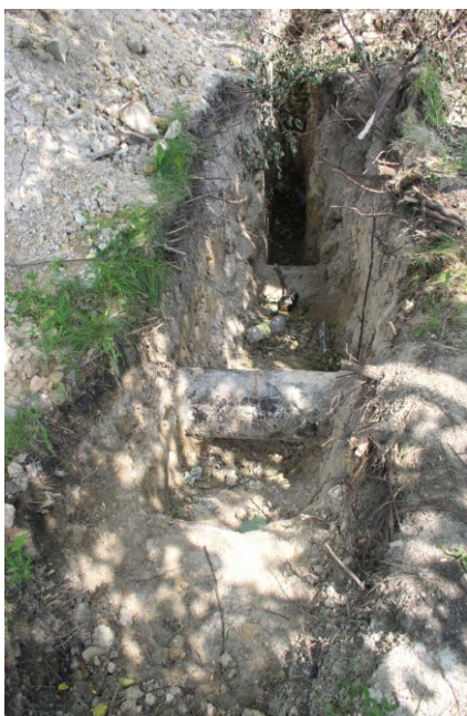
Fot. 2. Wykop wykonany od strony żywopłotu – dwie rury w miejscu występowania anomalii wysokooporowej
