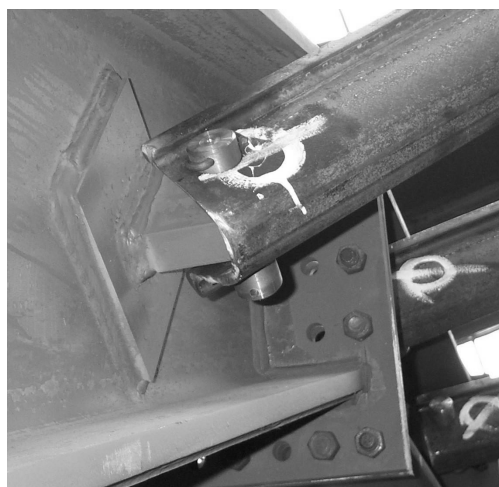
Fot. 1. Łącznik jednoprzegubowy (fot. M. Rotkegel)
